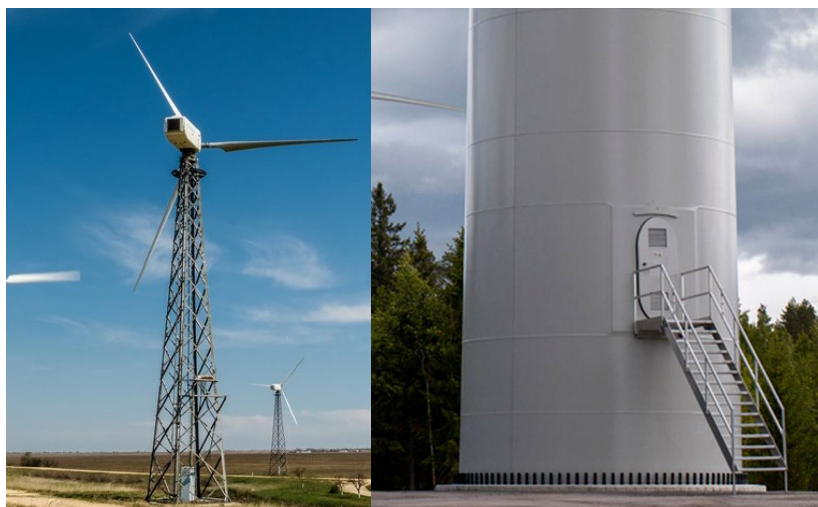
Рис.2. Конструкции башен ветроэнергетических установок: а) решетчатая б) сплошностенчатая металлическая
