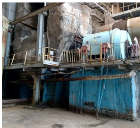
Рис. 1. Вентилятор двухстороннего всасывания ВДН-25×2 с электродвигателем мощностью 2,5 МВт
