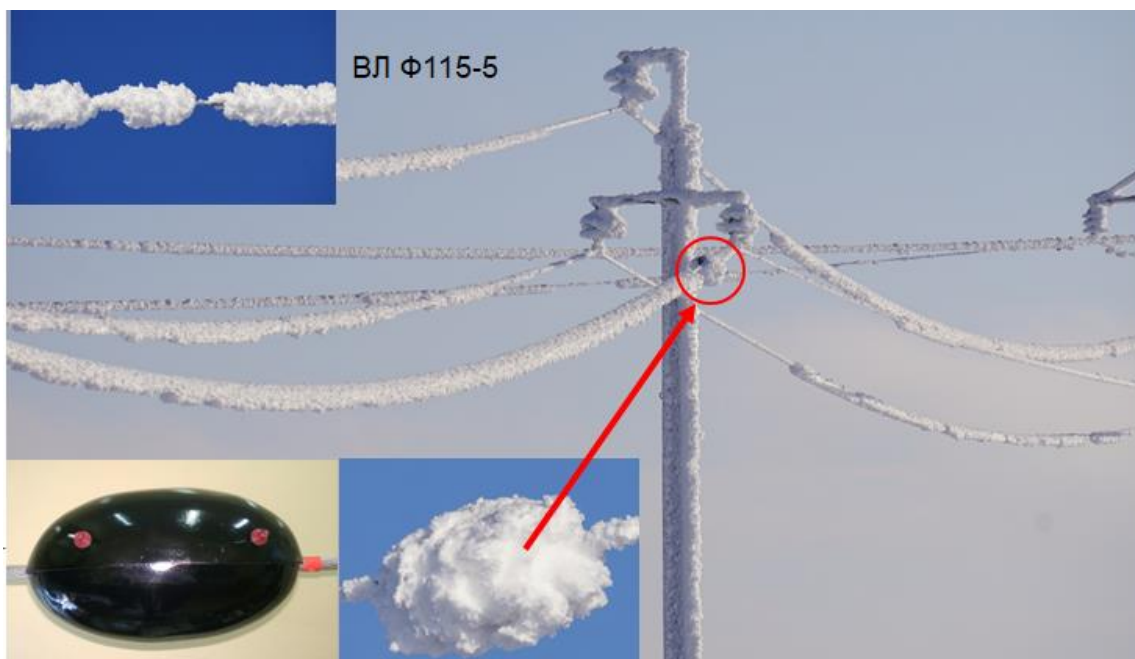
Рис. 2. Устройства установлены на ВЛ и организованы в сенсорную сеть
