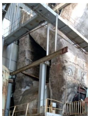
Рис. 2. Фасонные элементы воздушного короба котла ТГМЕ 464: а – разделение потоков на всасе, б – комбинация поворота на 135° с двумя поворотами на 90°
