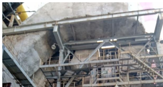
Рис. 2. Фасонные элементы воздушного короба котла ТГМЕ 464: а – разделение потоков на всасе, б – комбинация поворота на 135° с двумя поворотами на 90°
