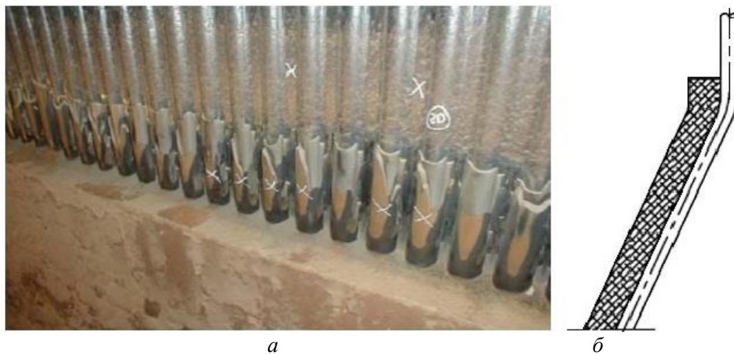
Рис. 3. Выступ слоя футеровки: а) на действующем котле; б) схематическое изображение
