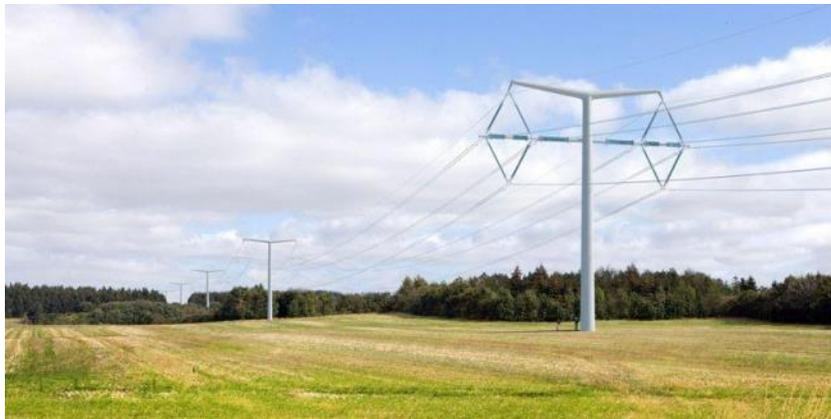
*Рис. 1. Вариант опоры ЛЭП Bystrup*
